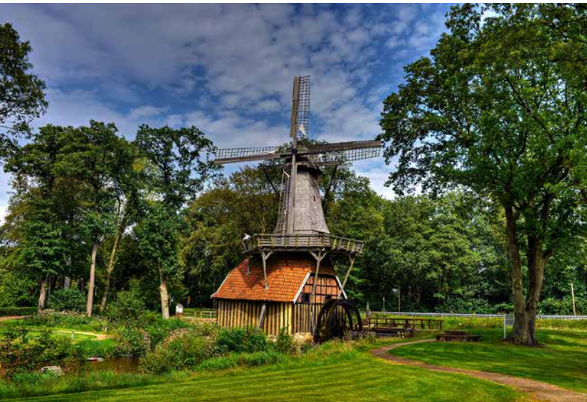
Samtgemeinde Sögel, Hübener Mühle, erste Hälfte des 16. Jahrhunderts erbaut, seit 1850/51 Wasser- und Windmühle
