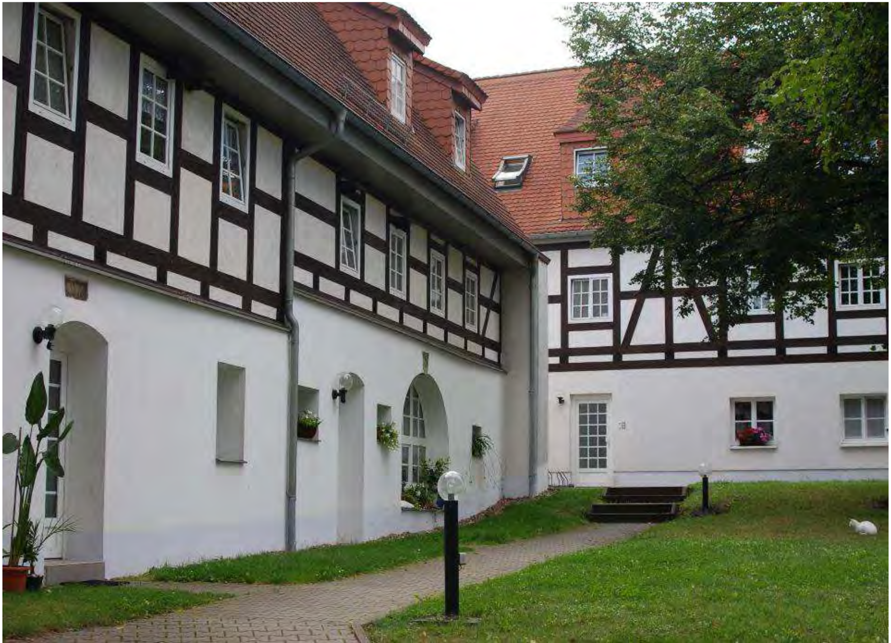
Umbau zu Eigentumswohnungen: Hühndorf
