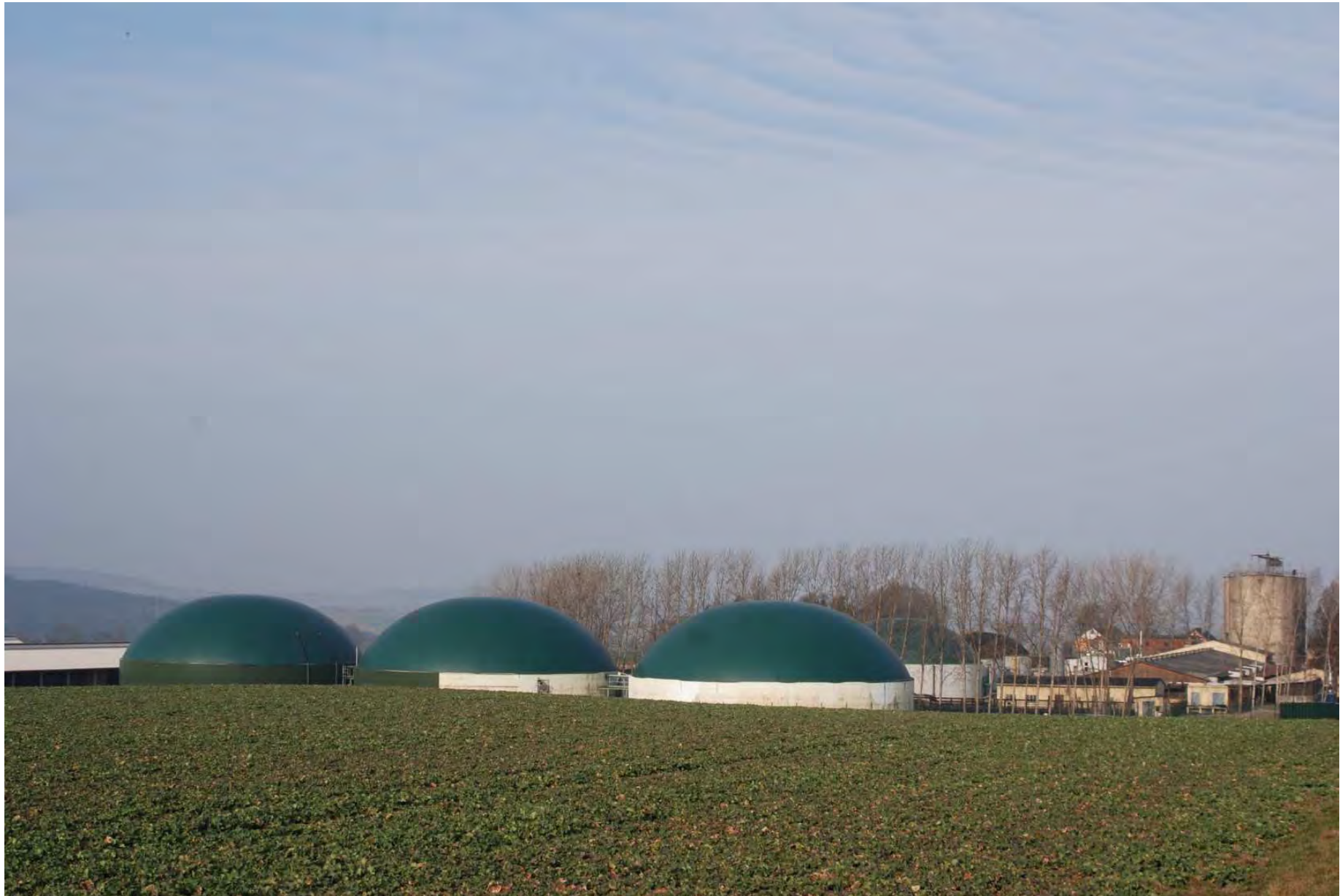
Großanlagen: Biogasanlage Reichenbach/V.
