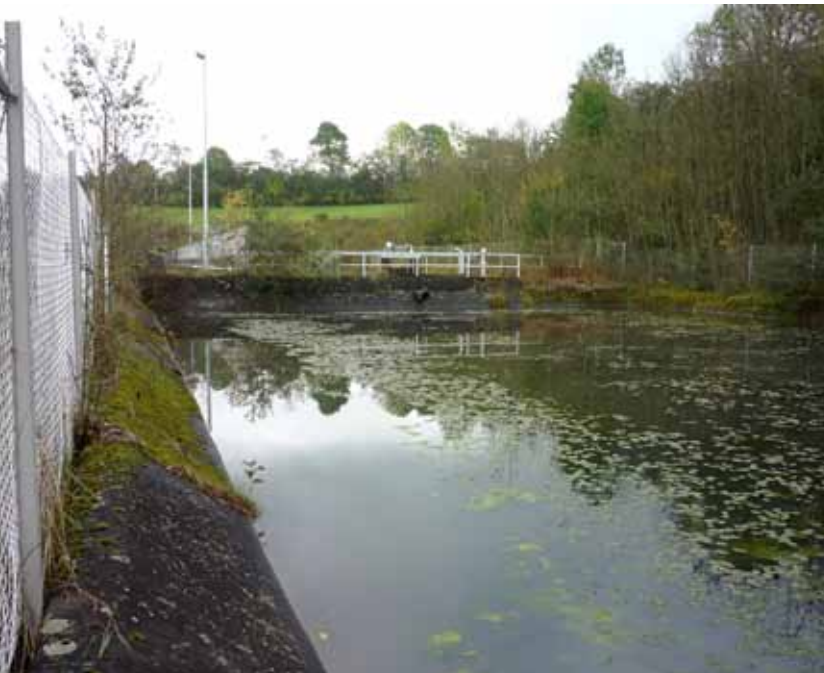
Panzerwaschanlage am Oschenberg vor Beginn der Rückbauarbeiten
