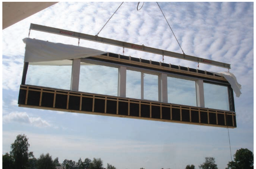
Die Außenwände wurden vorgefertigt und montiert.
