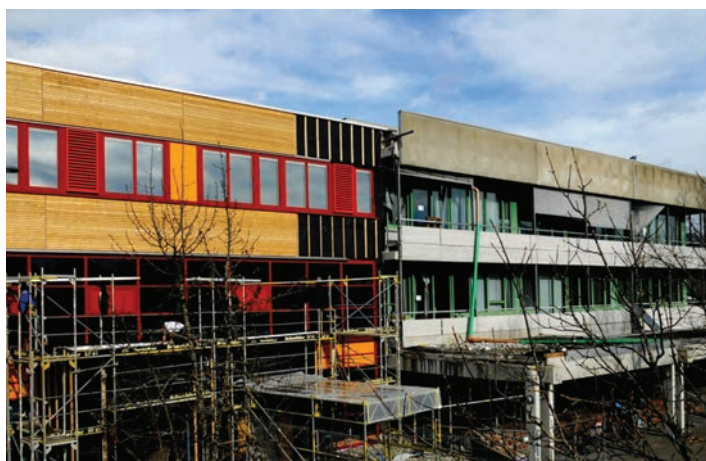
Neue neben alter Bausubstanz: Die vorgehängten Balkone wurden entfernt und die Fassade mit einer hochwärmedämmenden Holzverkleidung ausgestattet.
