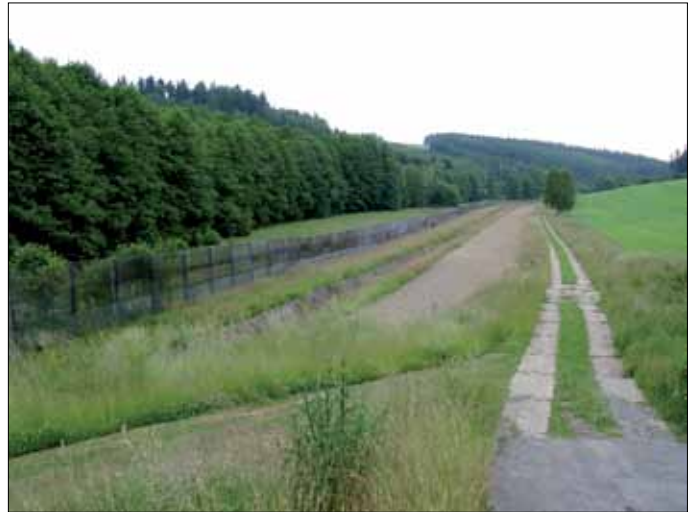
Reste der Grenzanlagen, wie hier nahe Mödlareuth, sind nur noch selten zu finden: Kolonnenweg, Kontrollstreifen, Kfz-Sperrgraben und vordere Grenzsicherungssperranlage (von rechts).
