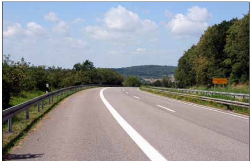
Ehemalige Reichsautobahn bei Eisenach, rechts Winterlinden-/Kirschgehölz zur Böschungssicherung, links Weißdorn mit vereinzelt Ahornen und Heckenrosen. Am Ende der Kurve beginnt das Ahorn-Lindengehölz. Hinter den Weißdornen liegt links der Talkessel von Eisenach, zu dem sich die Autobahn öffnet und über den sich die Wartburg erhebt.
