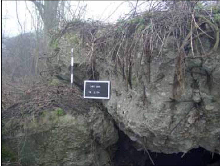
Vielorts blieben bloß noch Trümmer. Gesprengter Westwallbunker nahe Aachen.
